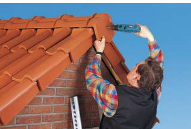
Zakończenie gąsiora kalenicy
