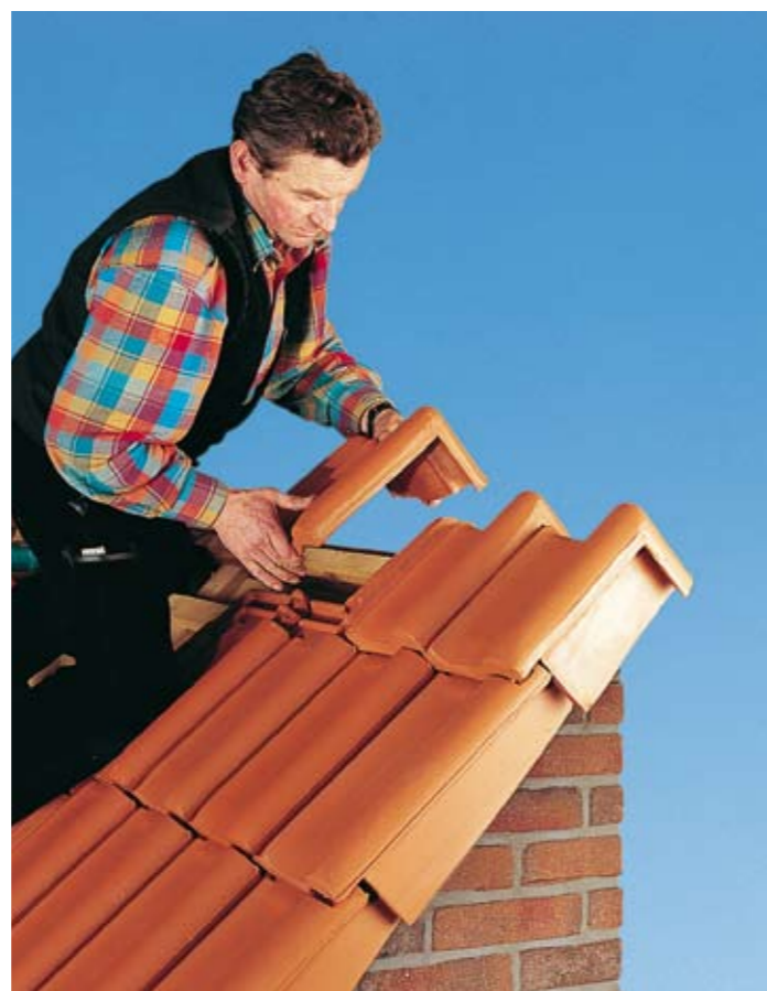
Montaż dachówki pulpitowej
